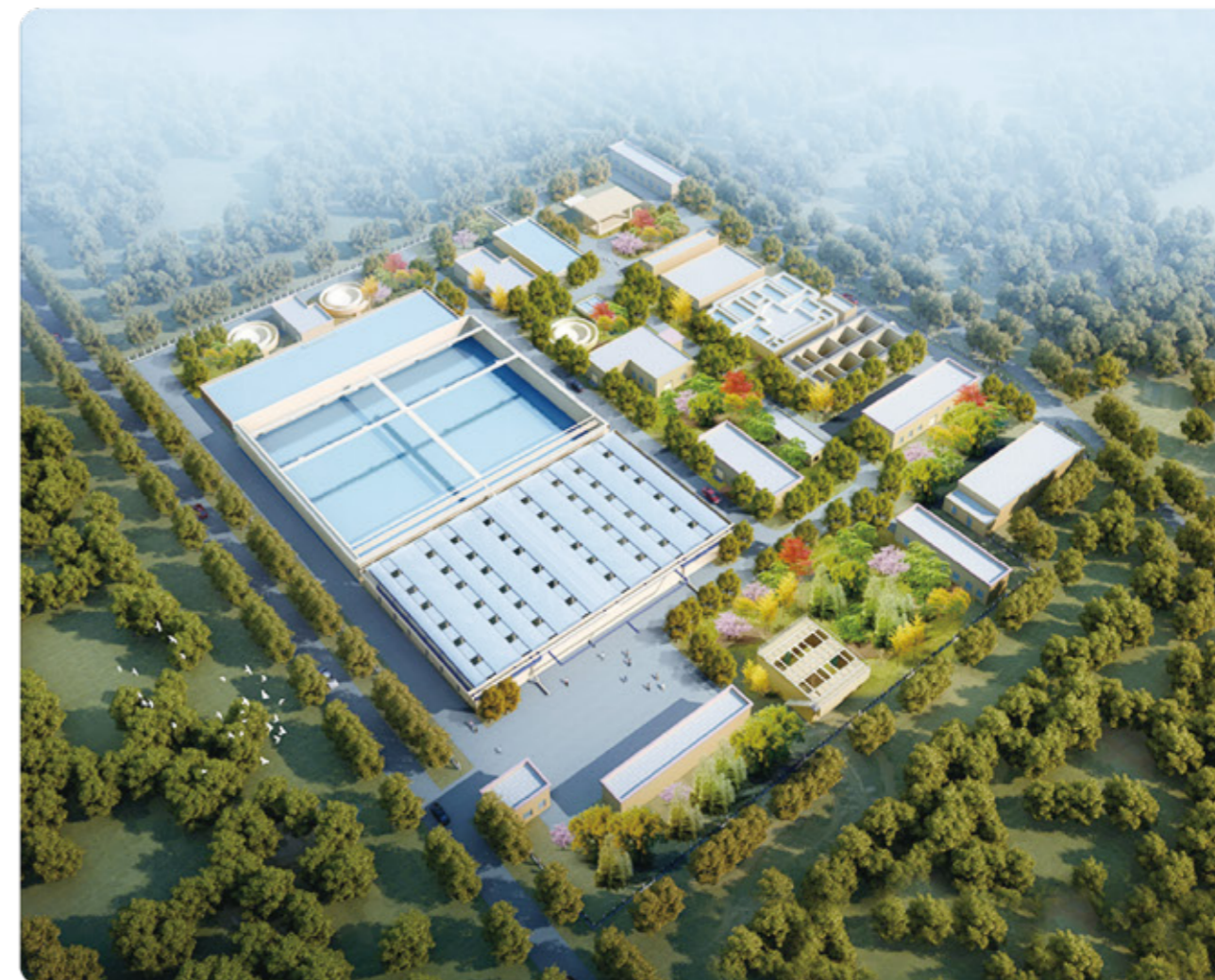
乳山市城区供排水PPP项目污水处理厂提标升级改造工程
