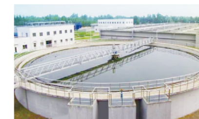
商丘水務有限公司污水處理廠一角
