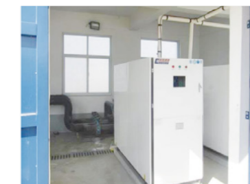
焦作污水處理廠污水源熱泵中央空調工程
