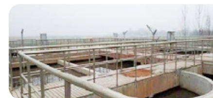
• 水解池改造现场图
