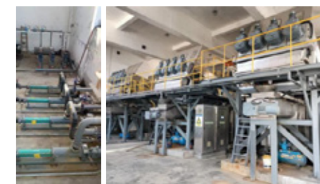
• 已建成两备一用三台污脱设备
